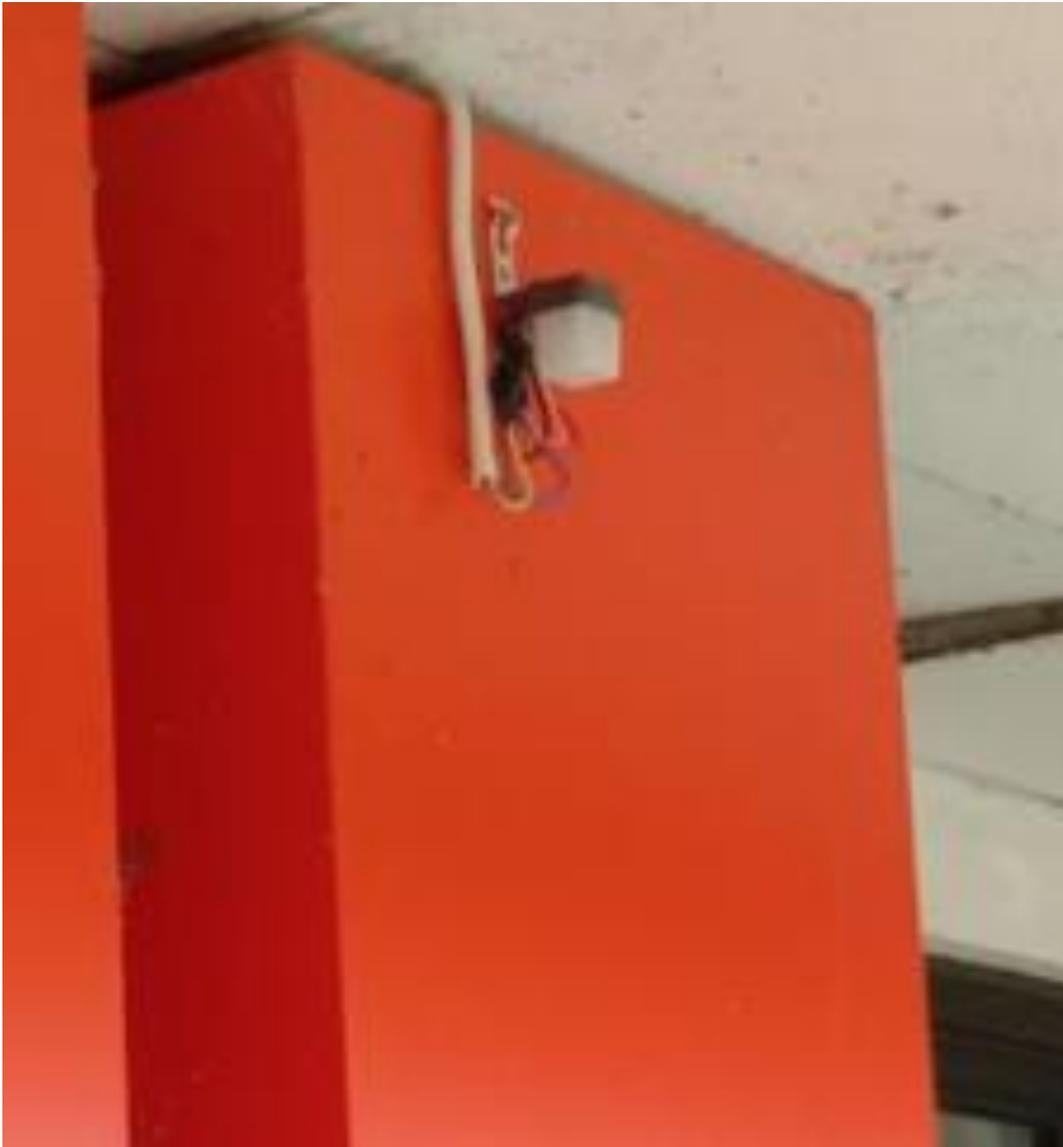
Gambar 25. Sensor Photocell
