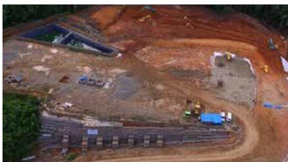
Gambar 8. Pemasangan *gabion wall* pada konstruksi *wellpad* di salah satu lapangan panas bumi di Indonesia.
