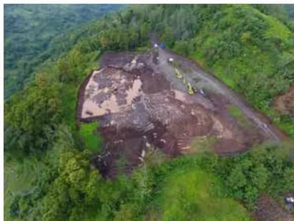
Gambar 7. Foto udara dari suatu tapak pengeboran (*wellpad*) yang sedang dibangun di salah satu area prospek panas bumi di Indonesia (Purba, 2018d).
