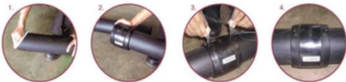
Gambar 5 Metode Penyambungan Electro Fusion Join
