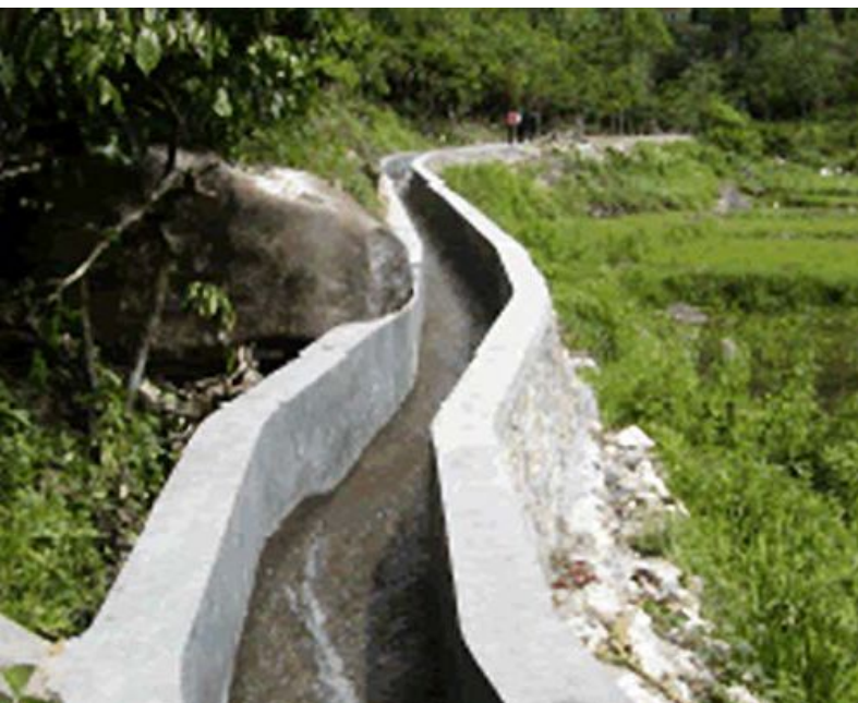
Gambar 6. Saluran Pembawa (Headrace)
