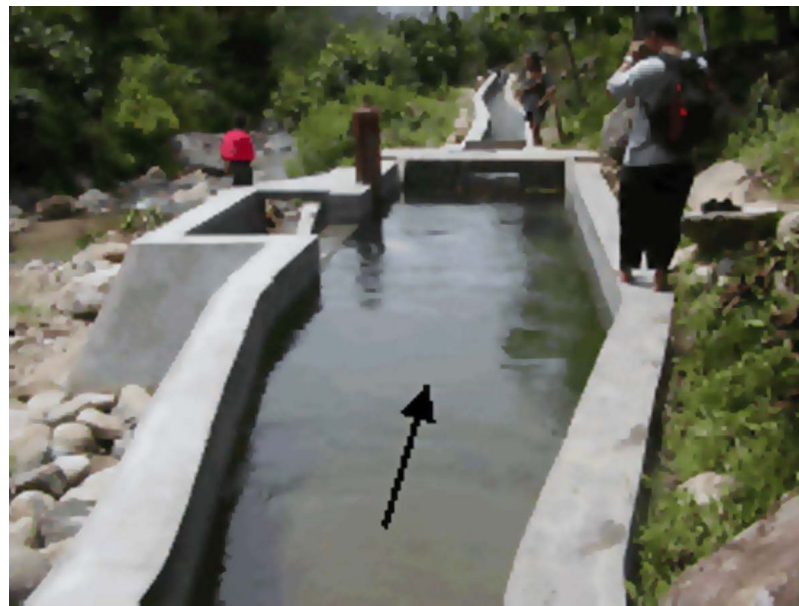
Gambar 4. Saringan (Sand Trap)
