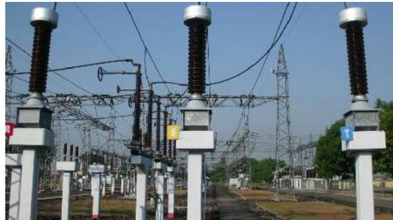
Gambar 1 Transformator Arus di Gardu Induk 150 kV
