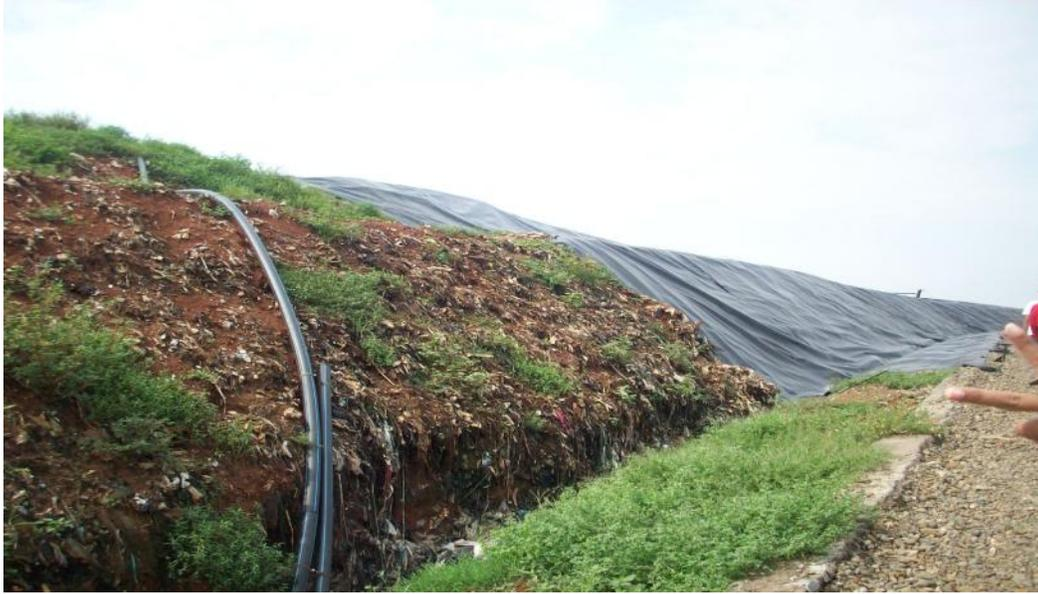
Gambar 5 : Gambar sanitary landfill ditutup dengan geo membran
