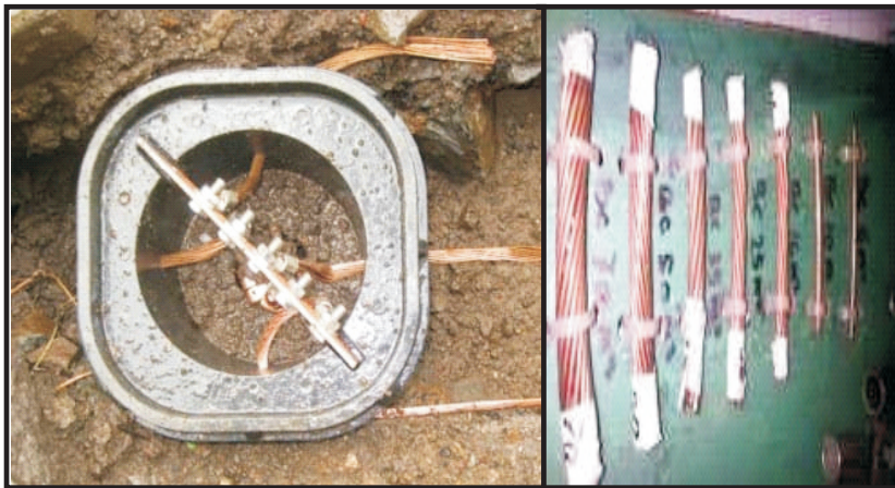
Gambar 7. Bak Kontrol Kabel BC
