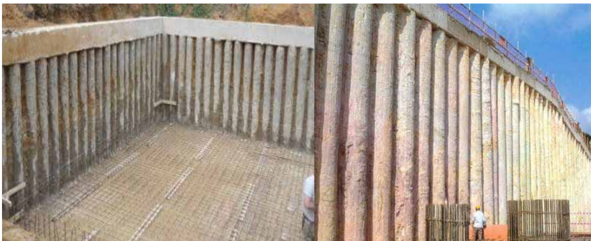
Gambar 14. Pile retaining wall (kiri) ; Gambar 15. Temporary pile retaining wall (kanan)
