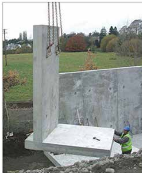
Gambar 7. Cantilever retaining wall (kiri); Gambar 8. Precast retaining wall (kanan)
